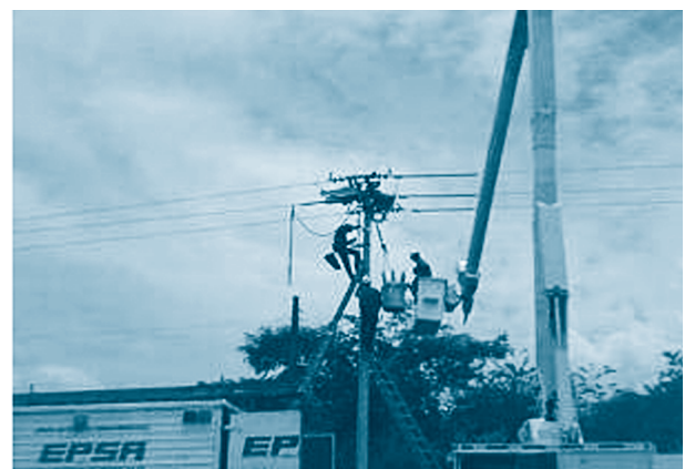
Figura 2. Mantenimiento en líneas energizadas.
